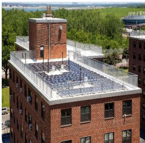
Отремонтирована крыша и система солнечных панелей в Ocean Bay (Бэйсайд)
