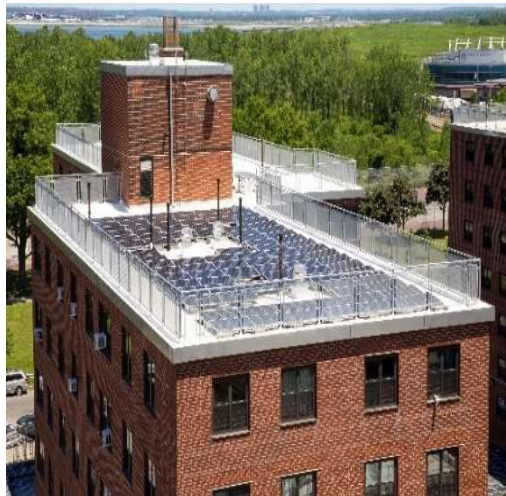
修复大洋湾 (Bayside) 的 屋顶和太阳能电池板系统
