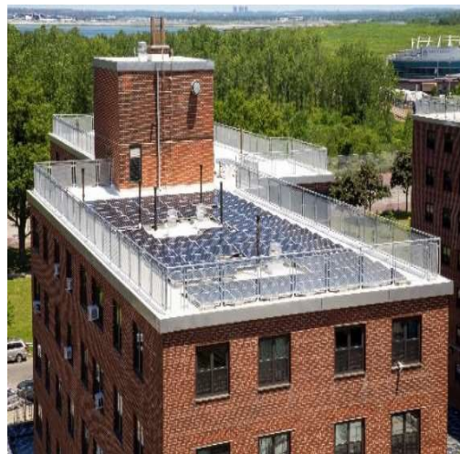
Techo reparado y sistema de paneles solares en Ocean Bay (Bayside)
