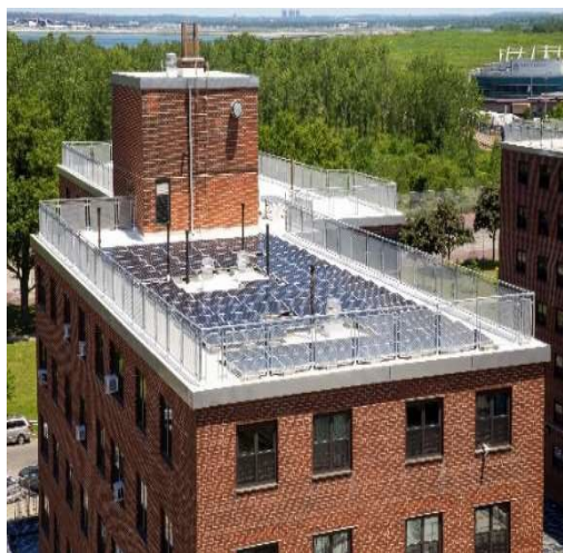
修復大洋灣(Bayside)的屋頂和太陽能電池板系統
